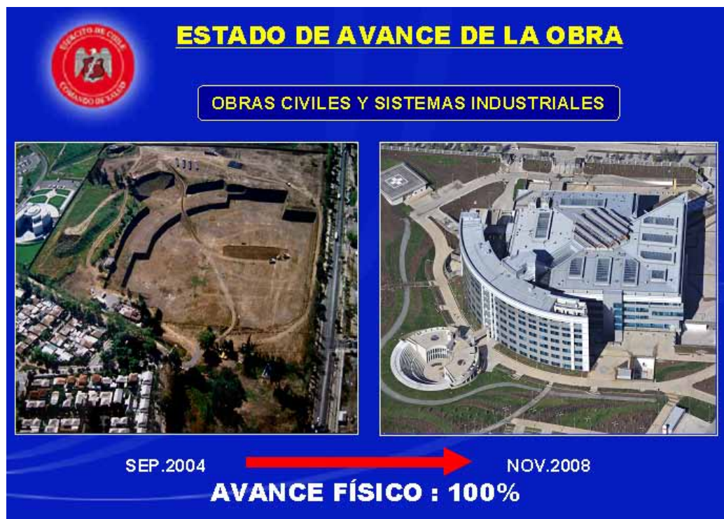
Estado de avance de la Construcción año 2008
